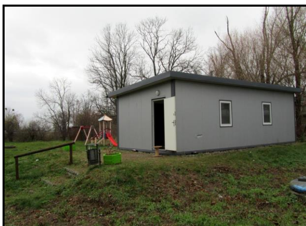
Kontenerowa sala wiejska
